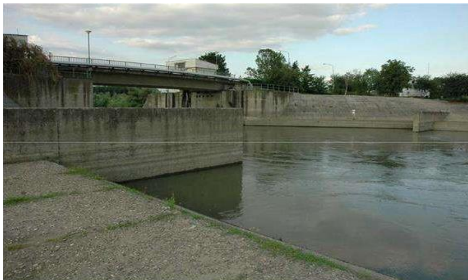
Слика 7. – Устава на Тамишу код Опова
