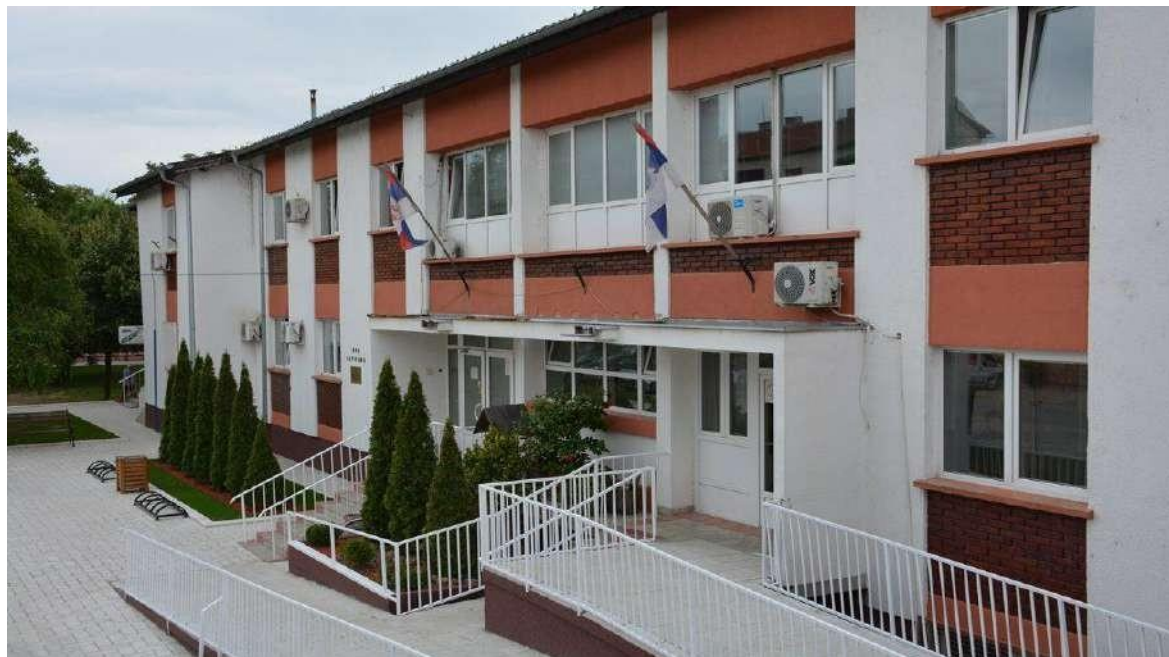
Слика 14. Дом здравља Опово
